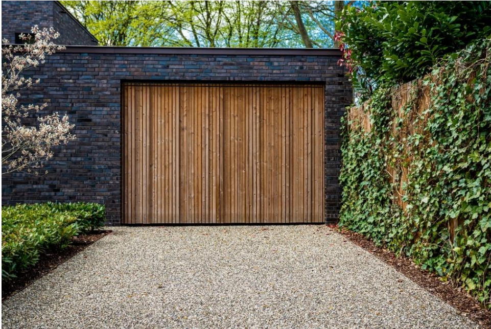
Abb. 8 zu 2.2.: Beispiel einer begrünten Einfriedung entlang einer Grundstücksgrenze (§ 9 Abs.1 Nr. 25 a BauGB)
